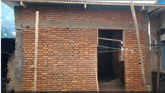
Boven de oude keuken, onder de nieuwe keuken in aanbouw
